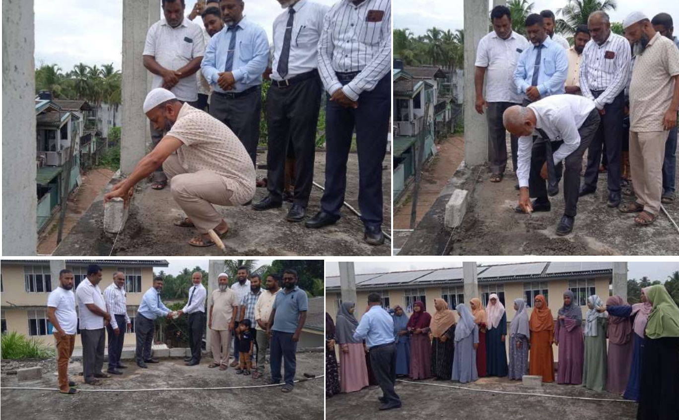
கஹுட்டோவிட்ட முஸ்லிம் பாலிகா மகா வித்தியாலயத்தின் குவைத் கட்டிட நிர்மாணப் பணியின் ஆரம்ப நிகழ்வு கடந்த 28 ஆம் திகதி வெள்ளிக்கிழமை நடைபெற்றது. கடந்த டிசம்பர் மாதம் பாடசாலை நலன்புரிக்குழுவினரின் ஏற்பாட்டில் நடாத்தப்பட்ட கிடுகு
